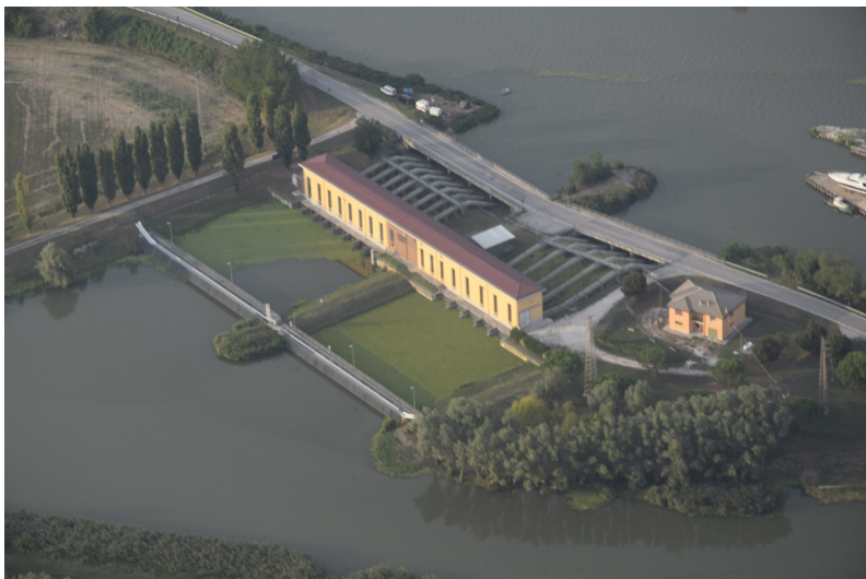
Idrovora di Cavanella Po da sud est
