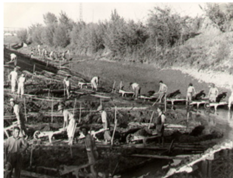
Fasi di scavo di un canale
