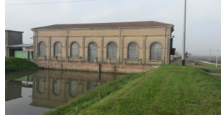
Idrovora “Tron” realizzata dall’ex Consorzio Santa Giustina nel 1925
