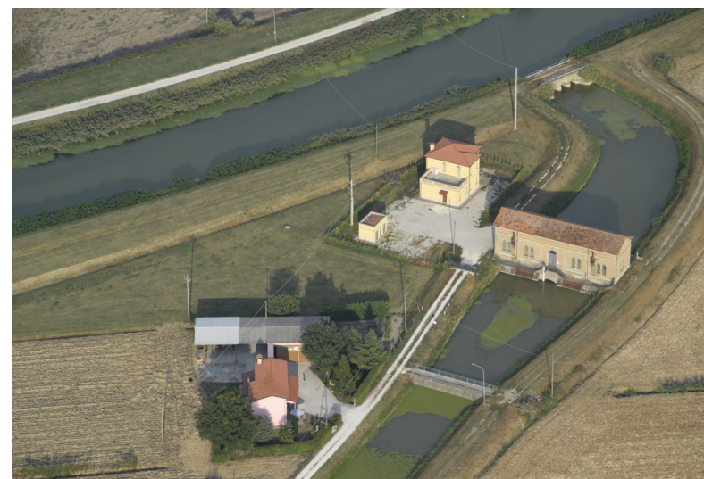
L' idrovora Ponte Foscari in comune di Adria
