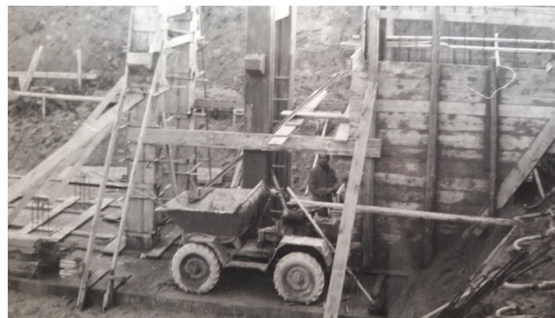
Fasi di costruzione dell'idrovora
