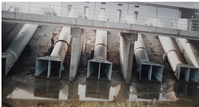
La costruzione delle bocche di scarico delle pompe
