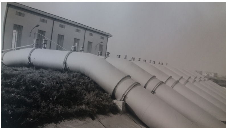
Le tubazioni appena posate
