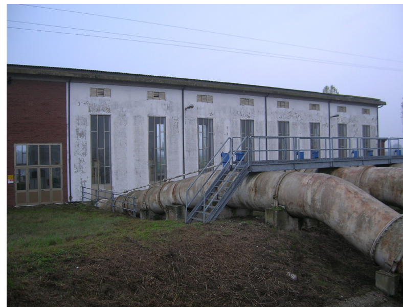
Fasi di costruzione dell'idrovora
