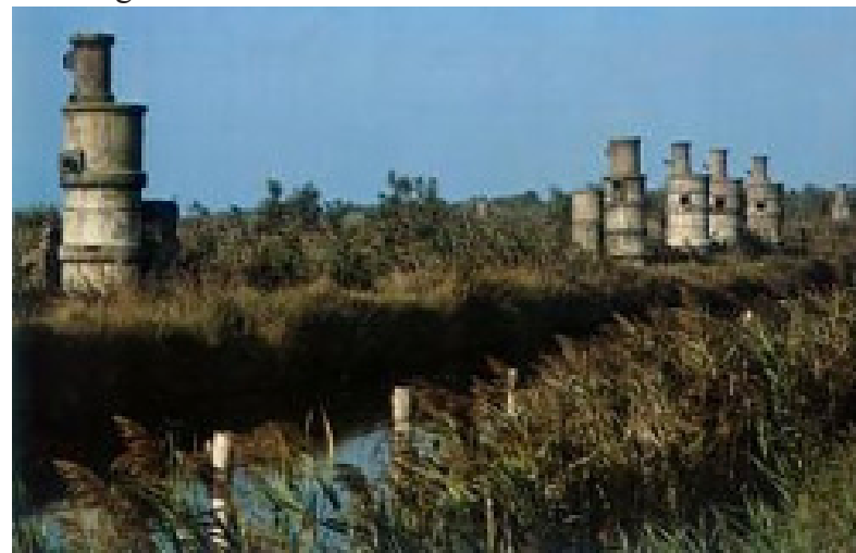
Vecchi pozzi abbandonati
