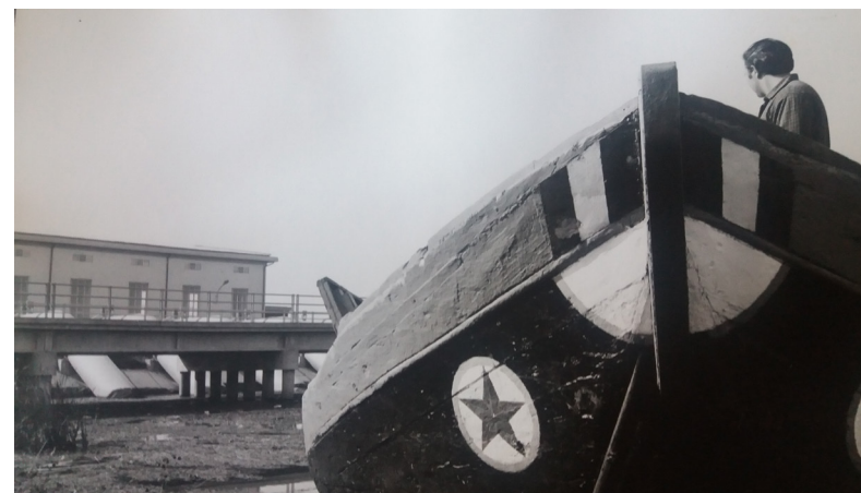
Il barcone utilizzato per i lavori da fiume
