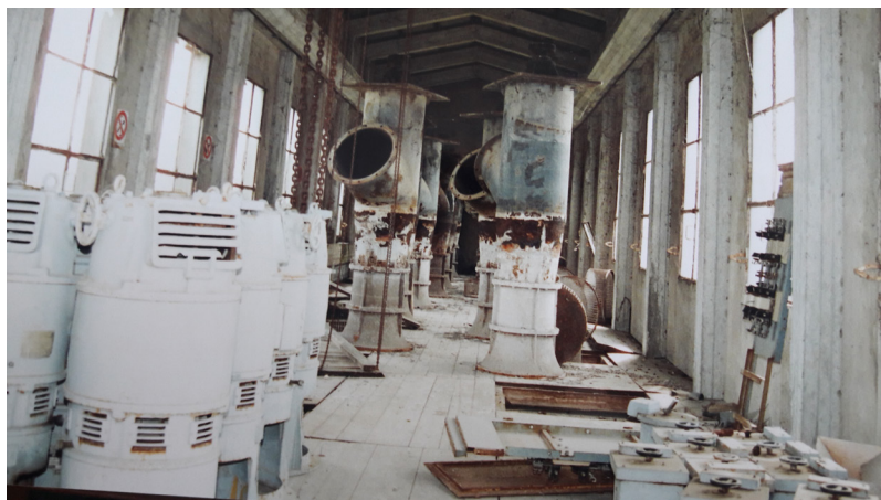
Il vecchio impianto provvisorio con 17 pompe "Pellizzari" in fase di montaggio
