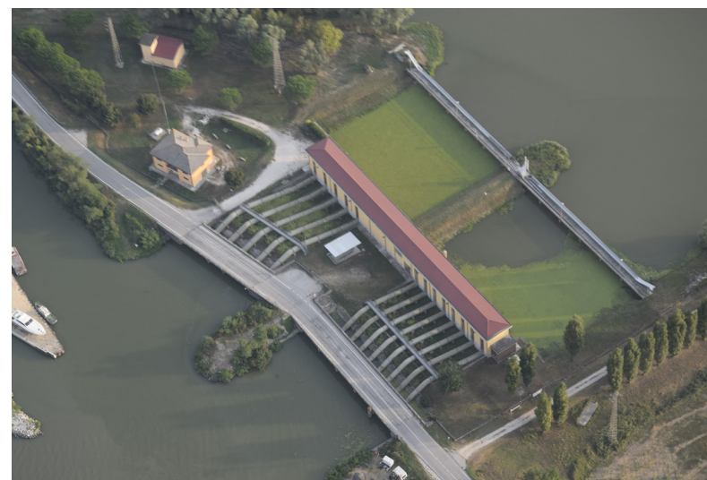
Veduta aerea dell'impianto
