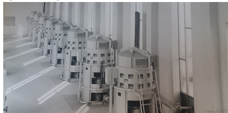
La sala macchine appena finita
