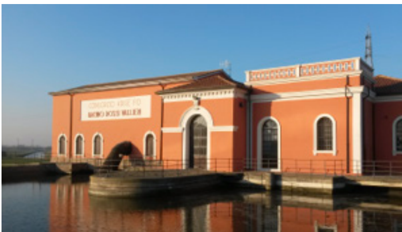
Impianto storico di Dossi Vallieri in comune di Loreo (1853) ancora funzionante
