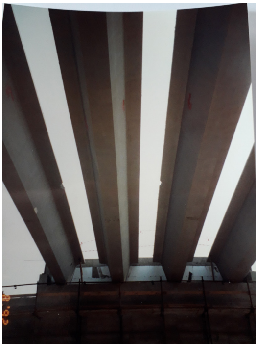
Particolare travi in c.a.p. del ponte allo scarco del mandracchio di Bussari (Consorzio Adige Canalbianco 1993)
