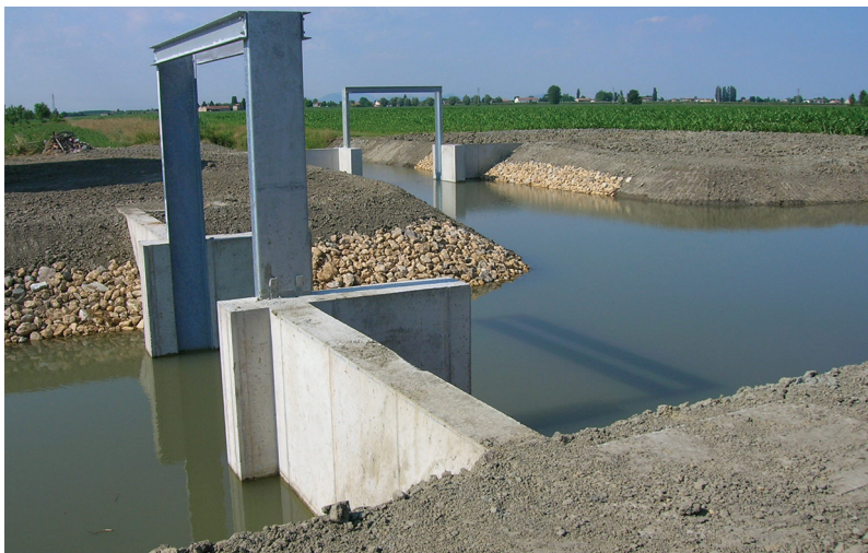
Costruzione manufatti di regolazione in località Molinella di Lendinara
