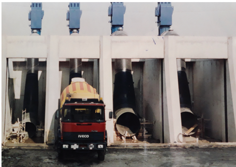
Costruzione impianto idrovoro Bussari (Consorzio Adige Canalbianco 1993)
