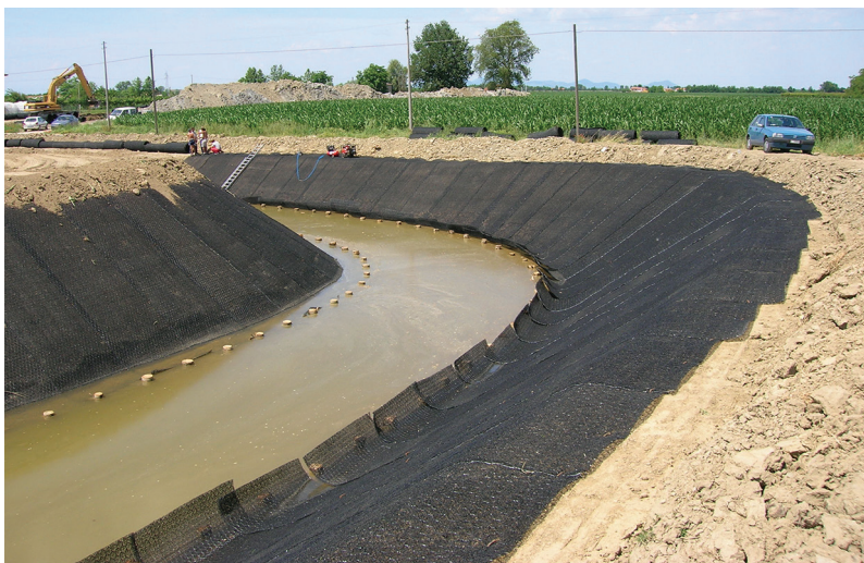
Costruzione del bypass in località Tre Ponti di Lendinara nel 2006
