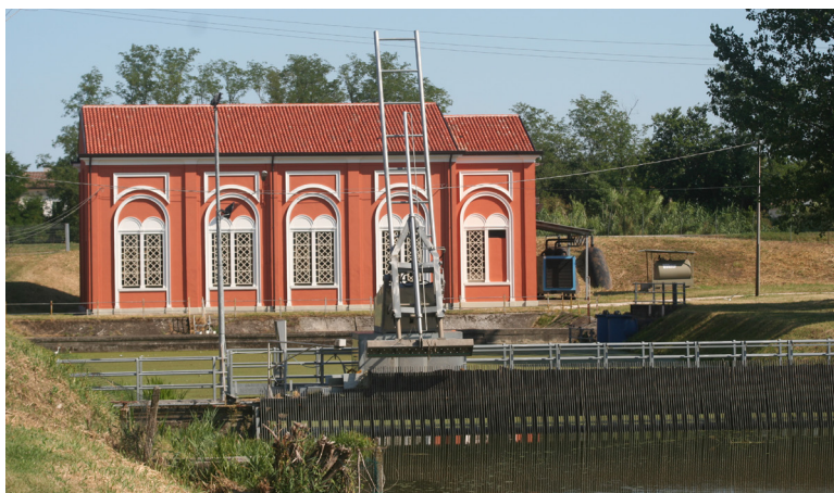
L'idrovora Ponti Altì (Consorzio di Bonifica Adige Canabianco 1997)
