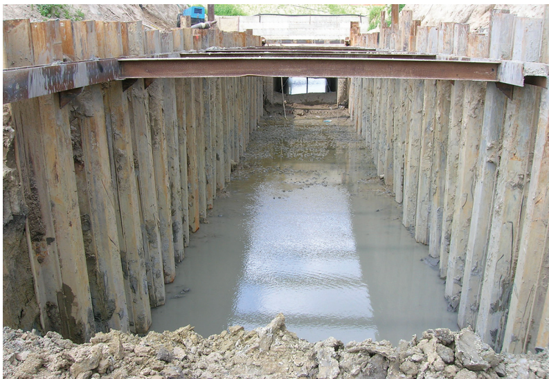
Doppia palancolata "Larsen" per la costruzione del ponte canale Fontana a Fratta nel 2005
