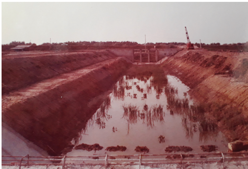
Costruzione canale di arrivo all'idrovora Bussari (Consorzio Medio Polesine Anni '70)
