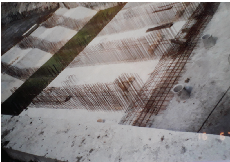
Costruzione platea impianto idrovoro Bussari (Consorzio Adige Canalbianco 1993)
