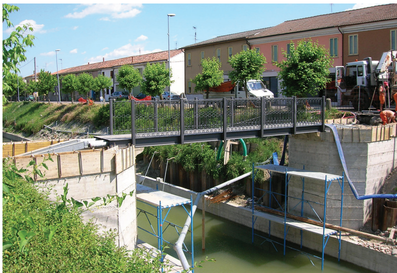
Ricostruzione passerella pedonale a Villamarzana
