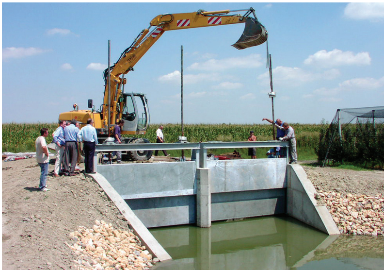
Fasi di collaudo della chiavica Trava a Molinella di Lendinara nel 2006
