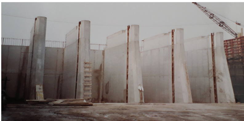
Costruzione setti del mandracchio dell'impianto idrovoro Bussari (Consorzio Adige Canalbianco 1993)
