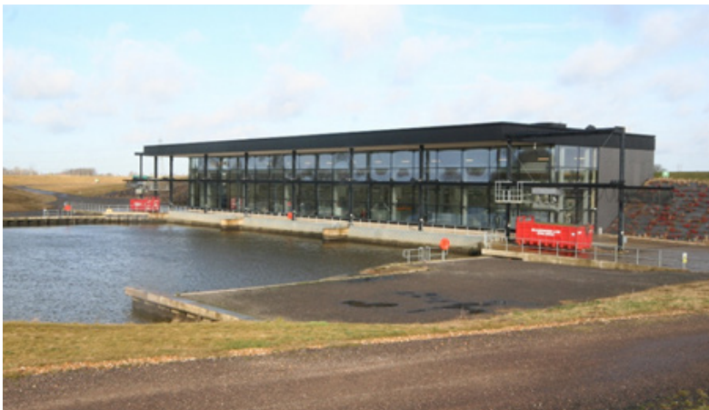
L'idrovora Saint Germain in Inghilterra da 100 mc/s
