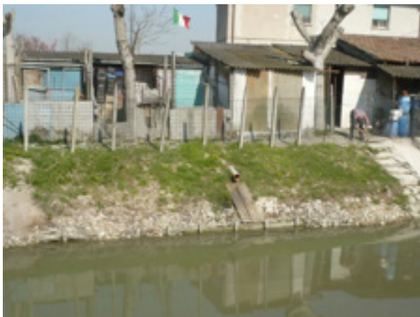
Situazione di degrado lungo i canali
