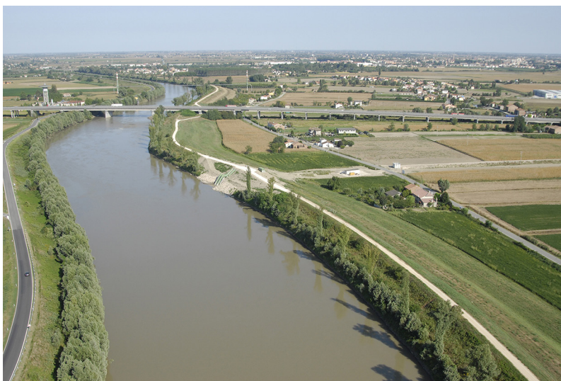
Veduta aerea del punto di presa
