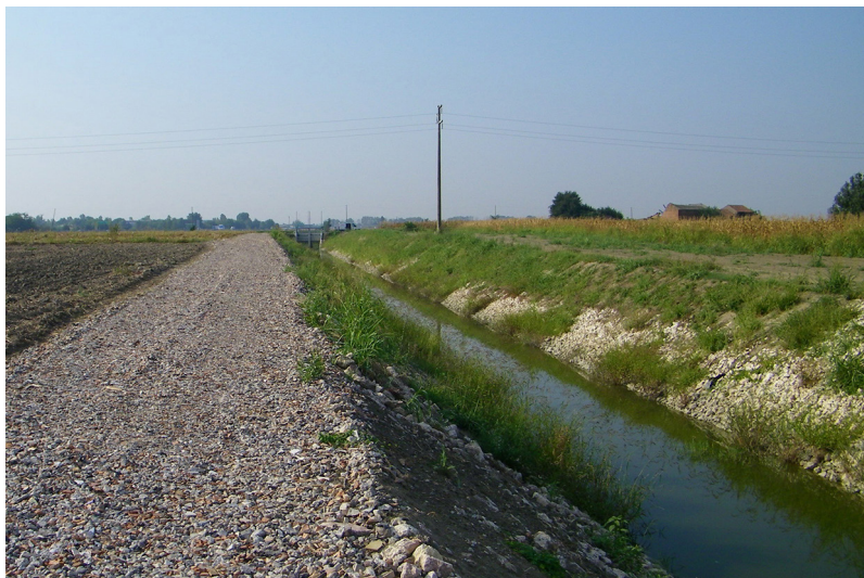
Costruzione canale di collegamento
