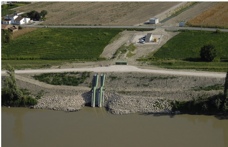
Veduta aerea del punto di presa Cantonazzo
