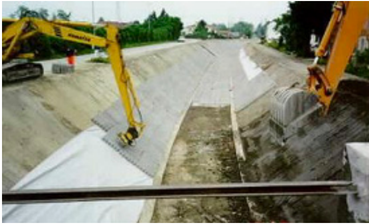
Posa del rivestimento in Adigetto
