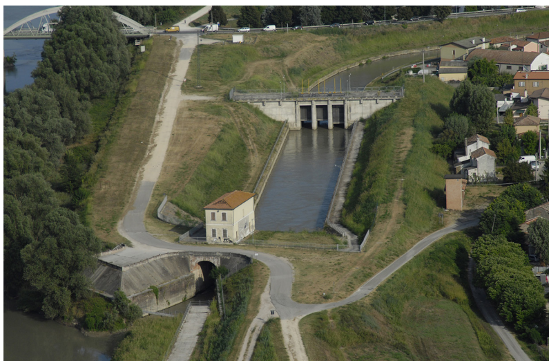
Veduta aerea dell'opera di presa Bova
