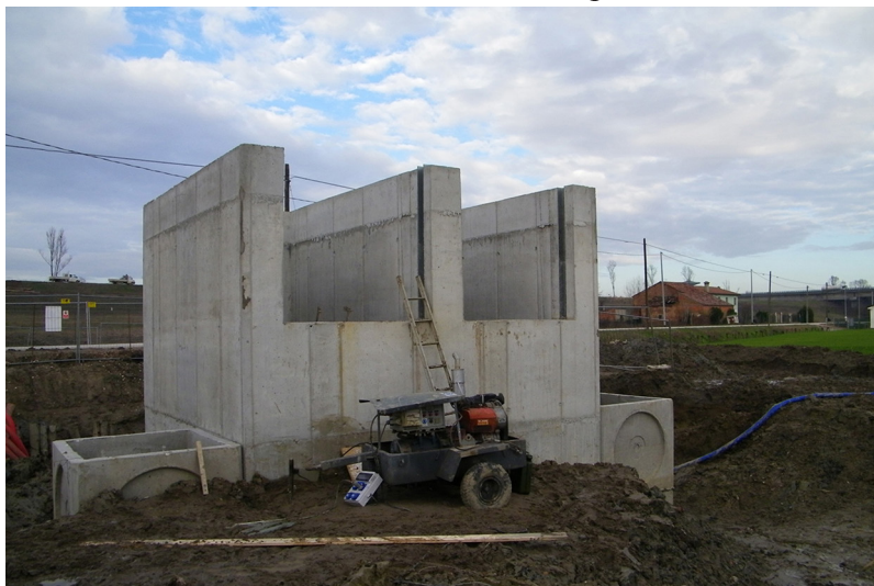
Costruzione torretta dissipatrice
