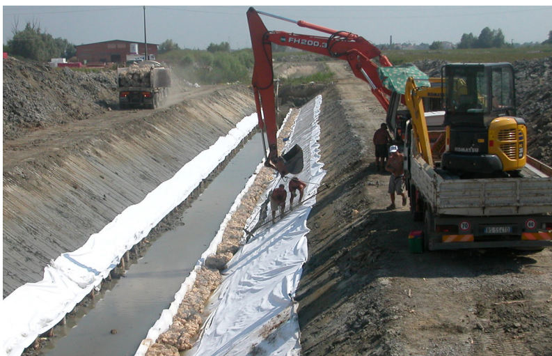
Realizzazione presidio di sponda in sasso
