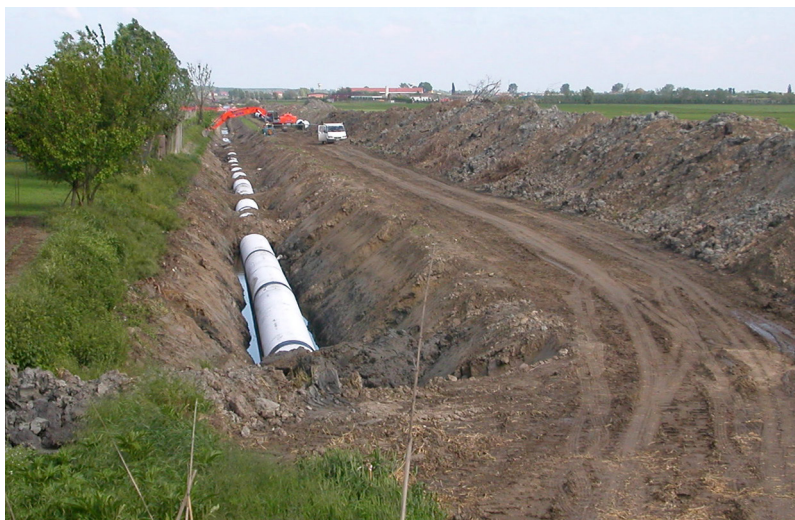
Posa tubazioni di mandata impianto Cavana
