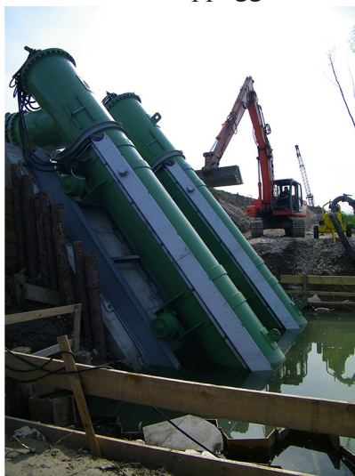
Realizzazione appoggi tubazioni
