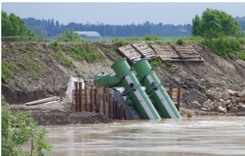
Fase di montaggio tubi contenitori in Adige
