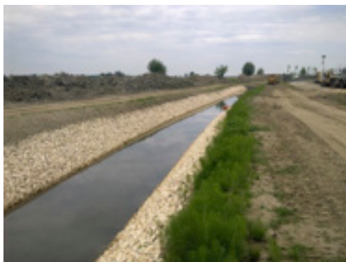
Canale di collegamento Rezzinella Adigetto
