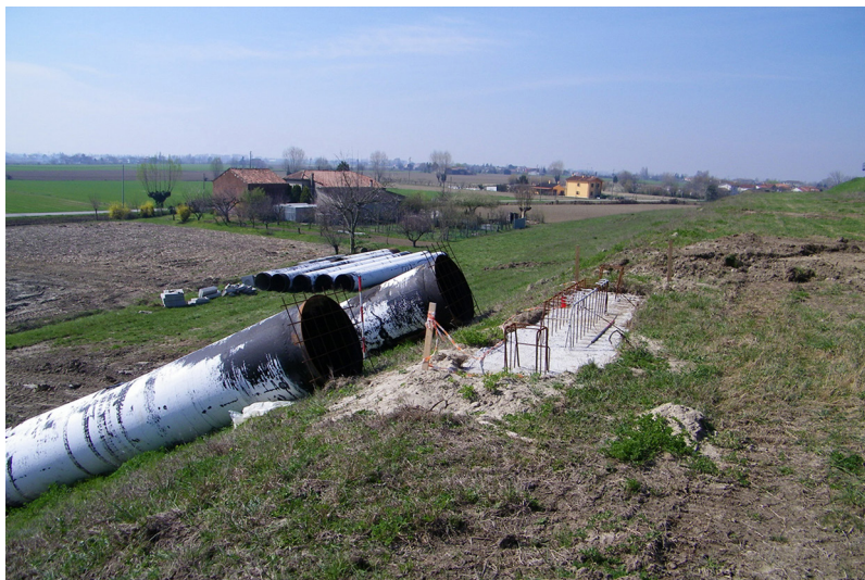
Realizzazione tubazioni a campagna
