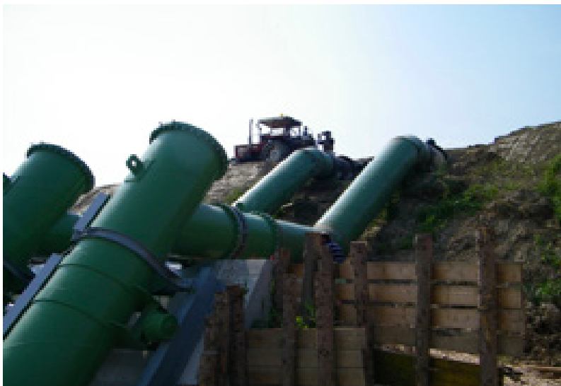
Realizzazione tubazioni a fiume
